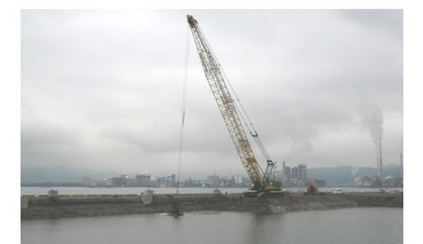
処理土投入状況
