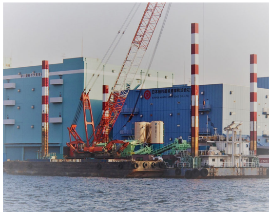
海上事前混合処理プラント
